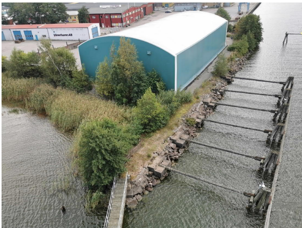
Bild 7 Erosionsskydd av sten och block i nordvästra delen av området
