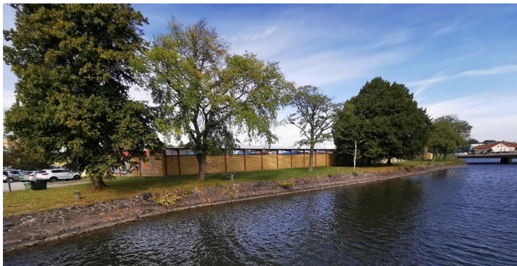
Bild 4 - Erosionskydd utförd som stenmur inom sydöstra delen av området mot Gamla Hamnkanalen
